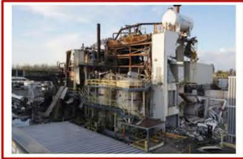
รูปที่ 1. ดักผลิตเรซินหลังจากเกิดระเบิดด้านใน (ที่มา: CSB report No. 2021-04-I-OH)
